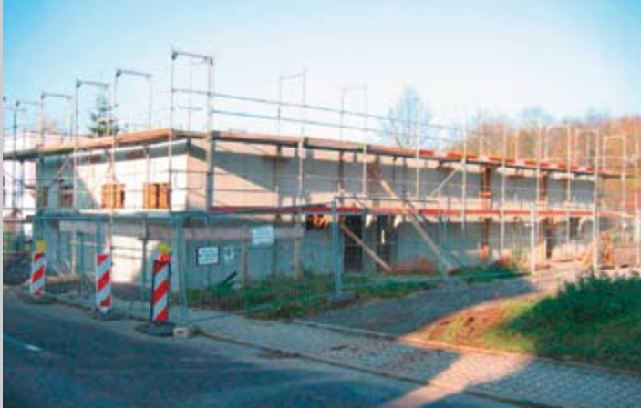
Neues Feuerwehrhaus im Rohbau
