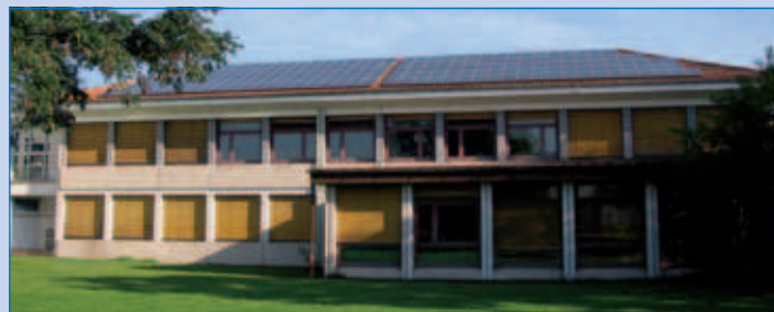
Realschule Sinzheim mit Photovoltaikanlage
