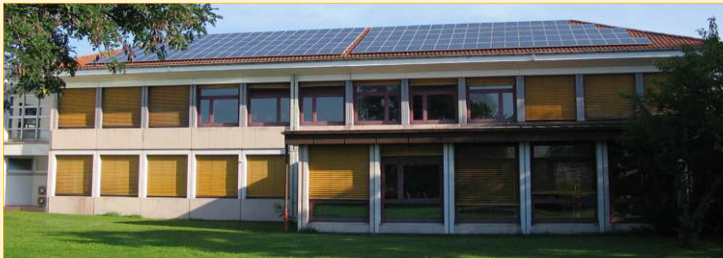
Realschule Sinzheim mit Photovoltaikanlage
