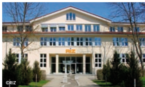
Das Radolfzeller Innovations- und Technologiezentrum, kurz RIZ, ist das flächenmäßig größte Projekt im Gewerbegebiet Nord.
