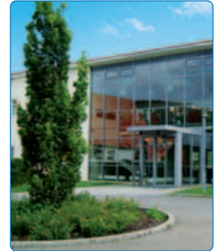
Altenzentrum St. Ulrich, Wehingen Foto: Boris Strehle
