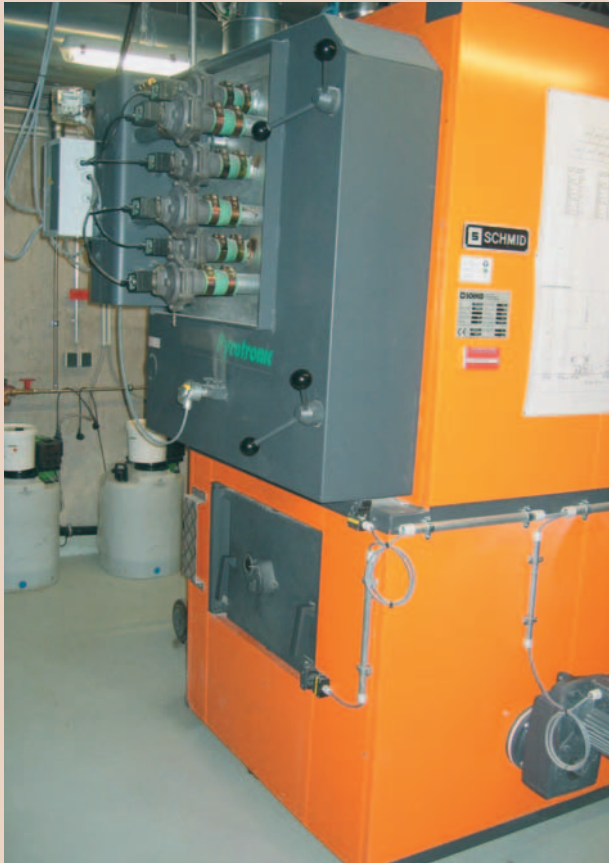
Klimafreundliche Heizung: Die mit Hackschnitzeln (unten) betriebene Anlage in der neuen LURS.
