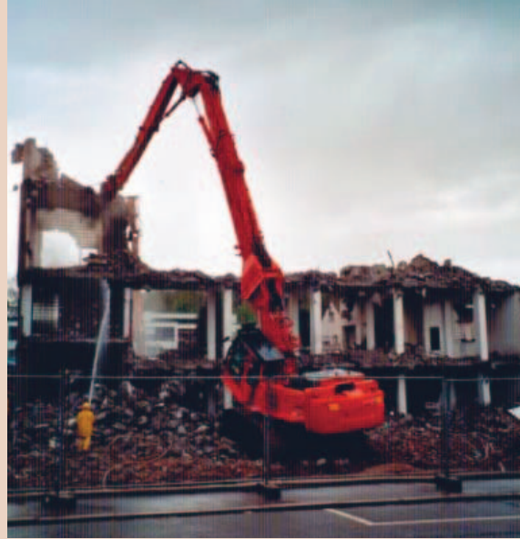
Abriss und Baggerbiss: Nachdem die alten Fabriken auf dem Sax-Areal verschwunden waren, konnte der Bau der LURS beginnen.
