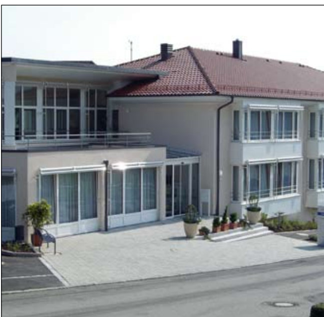
Altenpflegeheim Brühlstraße – Außenansicht
