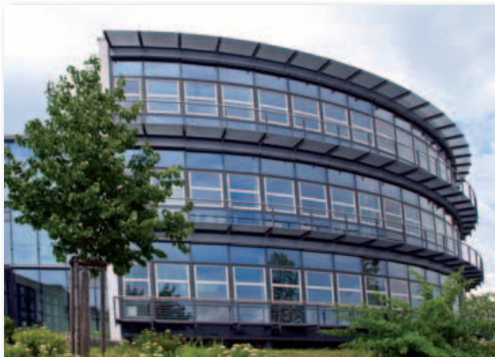
Moderner Rundbau Gewerbeschule
