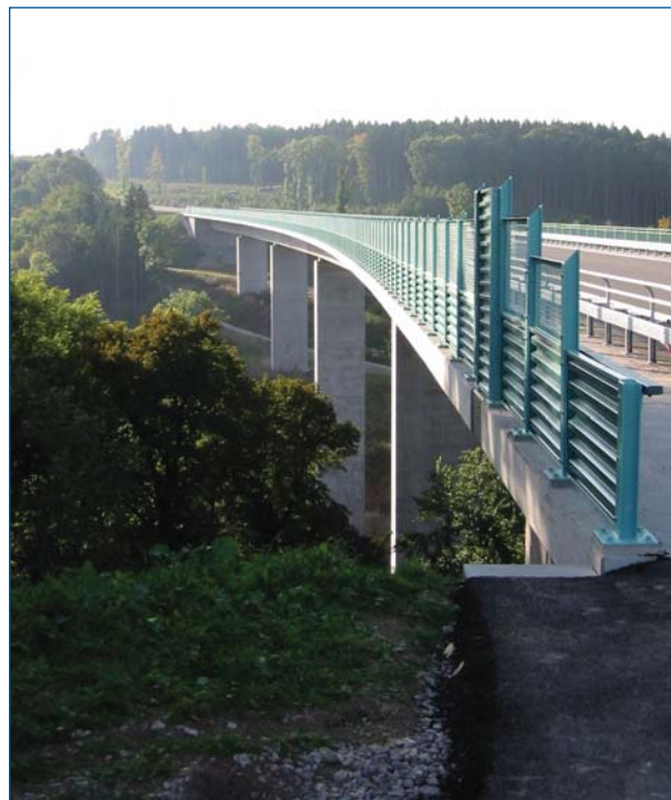
Nordumgehung Rottweil, Brücke über den Neckar, Foto: Ulrich Kühn, Straßenbauamt Donaueschingen, Bauleitung Rottweil
