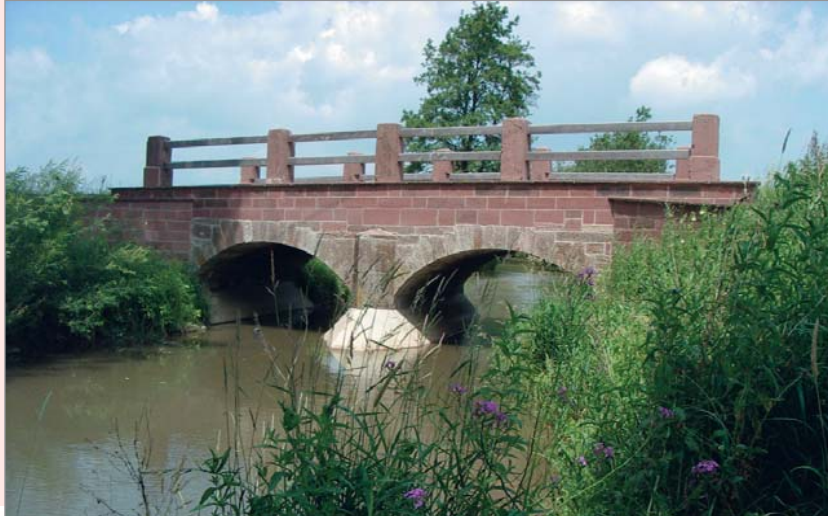
■ Brücke über die Eschach
