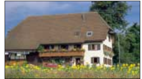
Haus Ernst Heizmann in Bach-Altenberg
