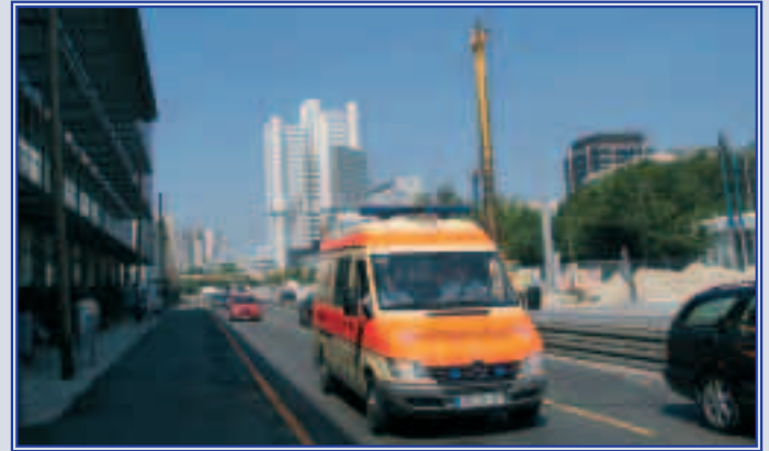
Großbaustelle Mittlerer Ring Ost, Blick zum Hypohauss
