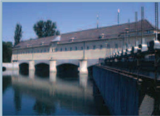
Isarstauwehr – seit 1921 wird das gestaute Isarwasser in den Mittleren Isarkanal abgeleitet
