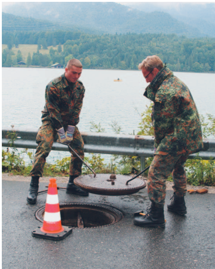
Wallmeistertrupp bei der Überprüfung der Verkehrssicherheit einer ehemaligen Sprengschachtanlage
