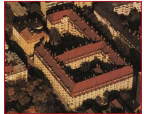
Bürgerheim-Block der Wohnungsgenossenschaft München-West
