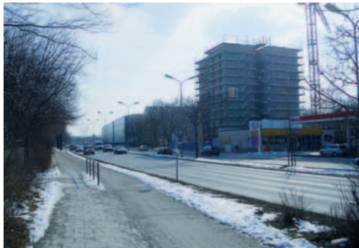
Innsbrucker Ring, Sanierung „Wohnen im Viertel“
