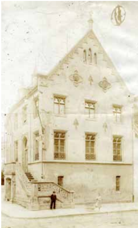
Altes Rathaus mit neugotischer Fassade vor dem Umbau 1908-09
