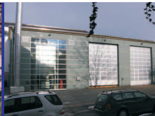
Fernwärmeversorgung (Hackschnitzelheizwerk Kemptelpark)
