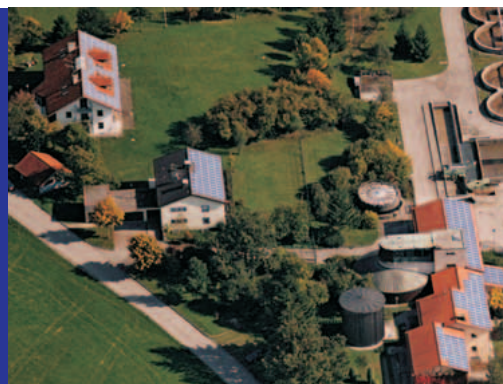
Stromerzeugung (Photovoltaikanlagen am Klärwerk)
