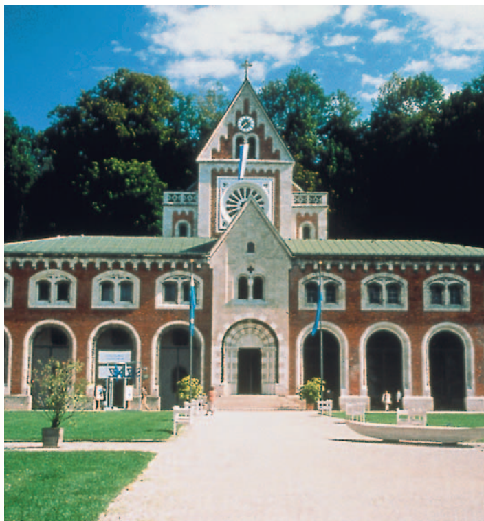
Alte Saline Bad Reichenhall
