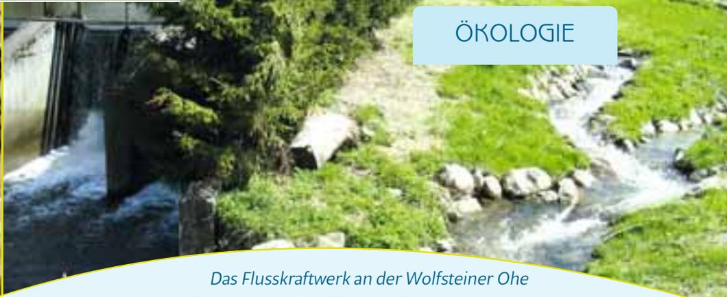
*Das Flusskraftwerk an der Wolfsteiner Ohe wurde mit einem Umgehungsgerinne ausgestattet*
