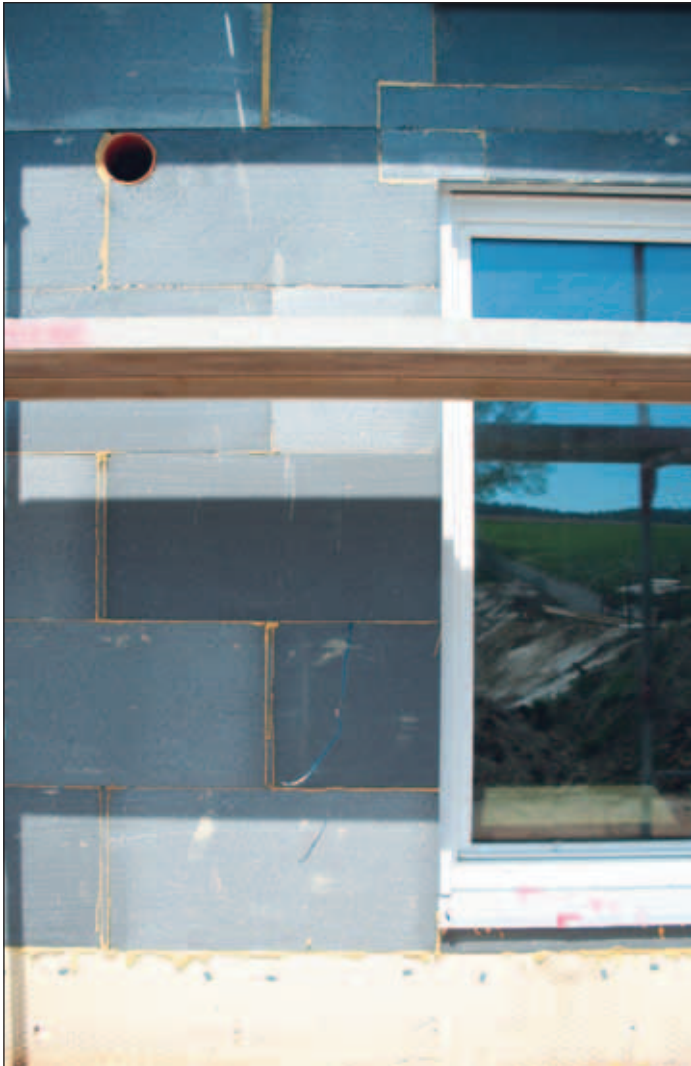
Fassadendämmung und vorbereitete Lüftungsanlage an einem Neubau
