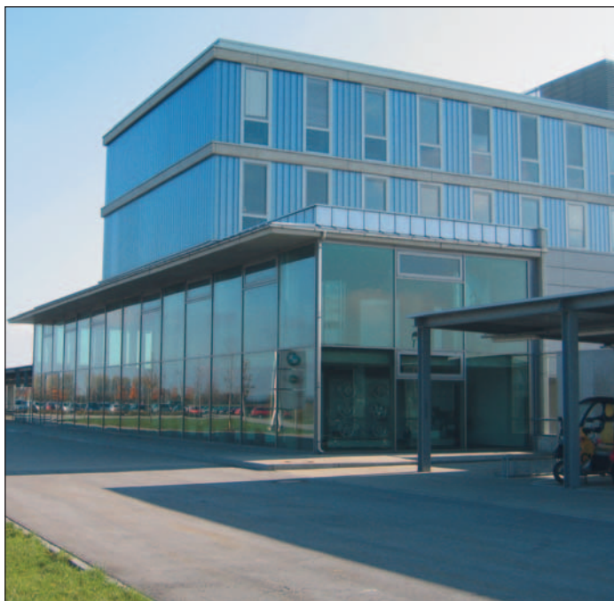
Fa. BMW, Ausbildungszentrum Dingolfing, A+P Architekten
