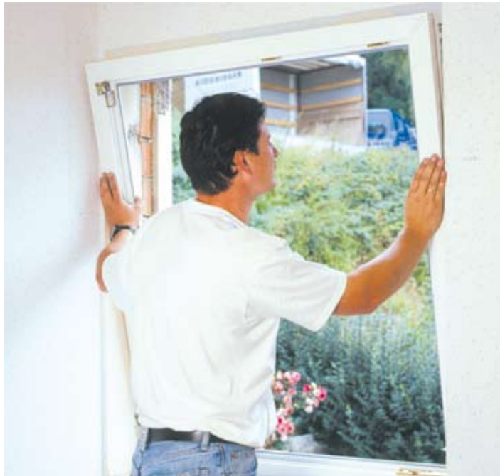
... danach werden die Neuen eingesetzt ...
