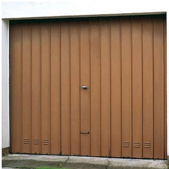
Das alte Tor vor der Sanierung.
