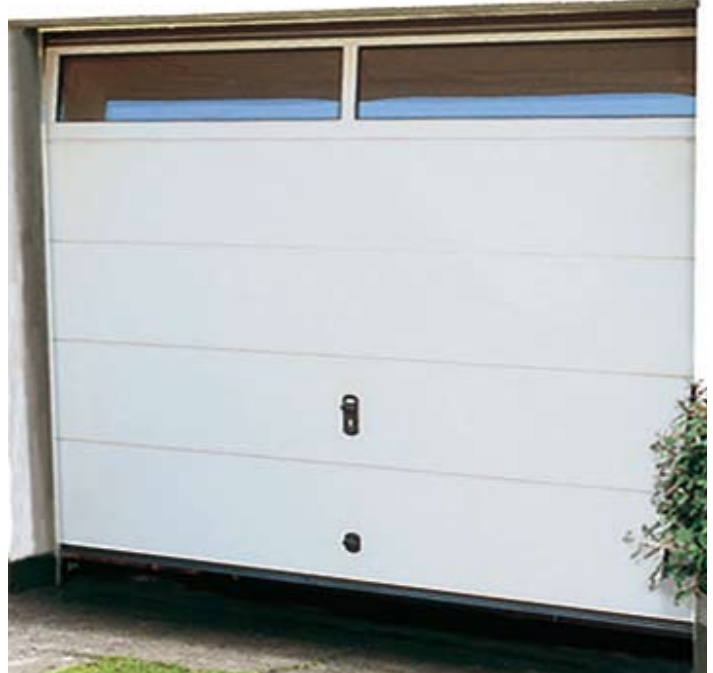
Das neue Sectionaltor nach nur wenigen Stunden fertig eingebaut.
