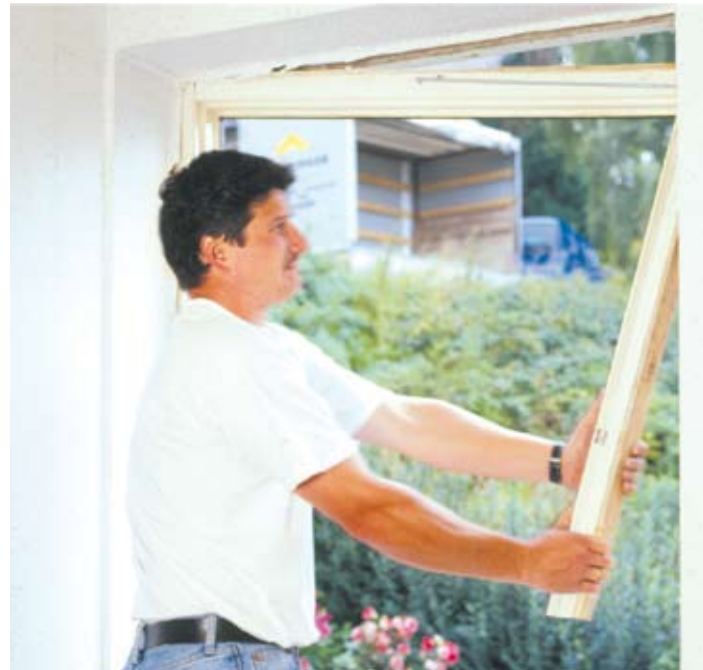
Ausbau- und Entsorgung der alten Teile ....
