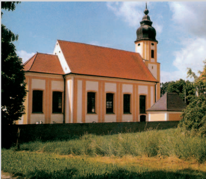
Pfarrkirche in Nassenfels
