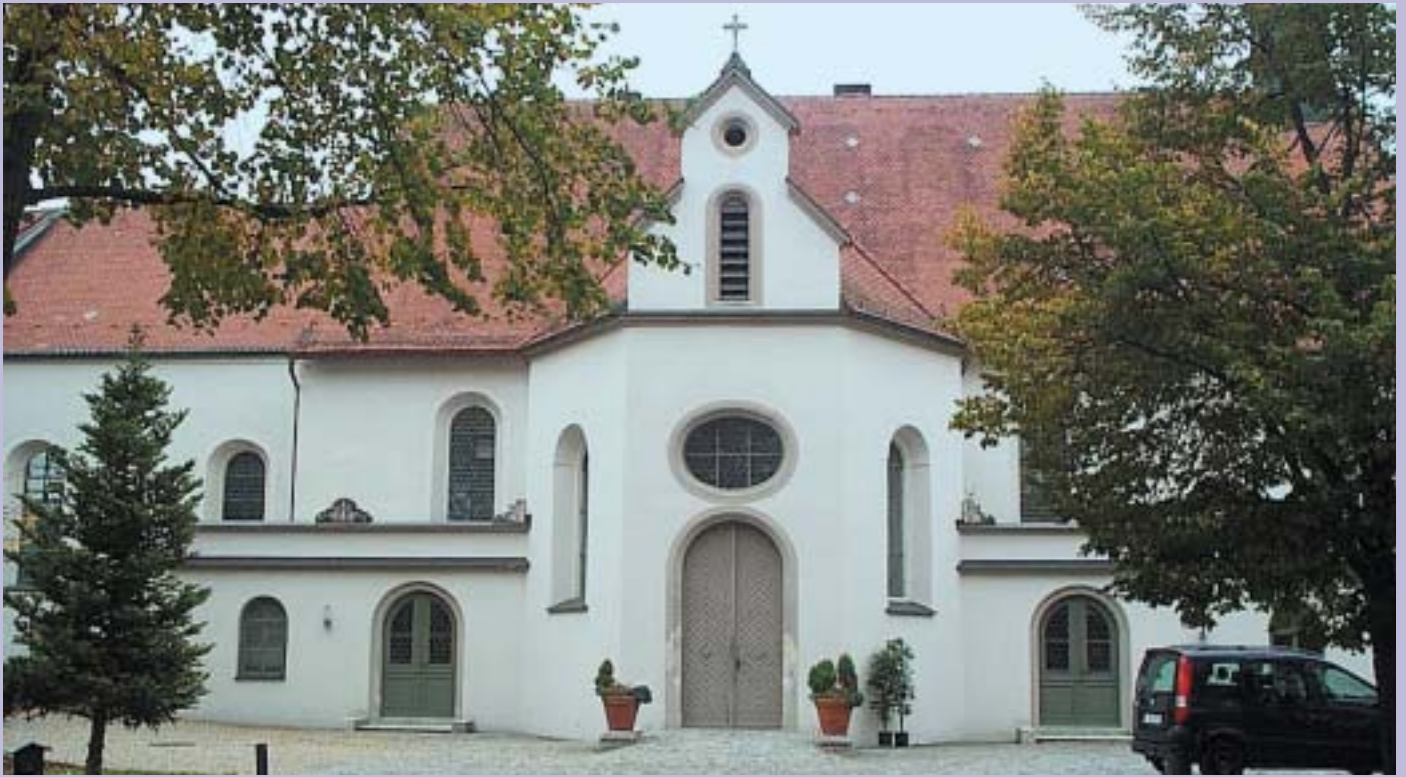
Aussegnungshalle mit Aufbahrungsräumen im Friedhof an der Franziskanerstraße
