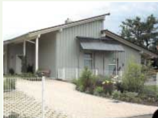
Solaranlagen als Terrassenvordach in Straße
