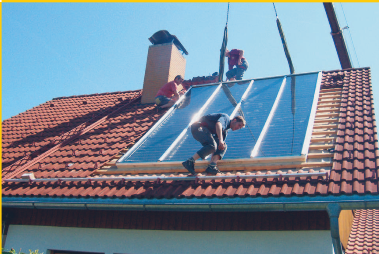
Montage eines Großflächenkollektors
