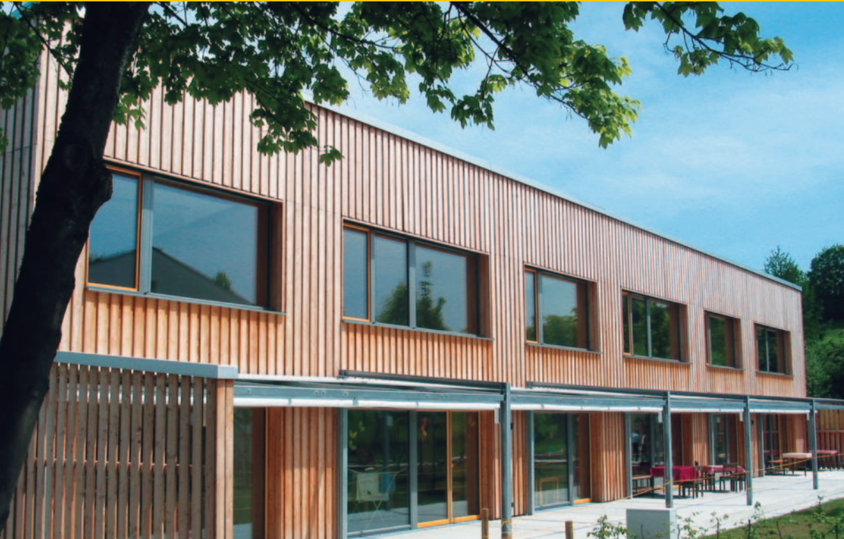
Kinderhort: Die Gruppenräume sind nach Süden orientiert und bieten mit der Terrasse einen hohen Komfort
