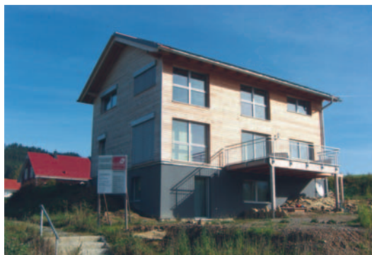
Durch die Hanglage können auch die Kellerräume optimal genutzt werden.
