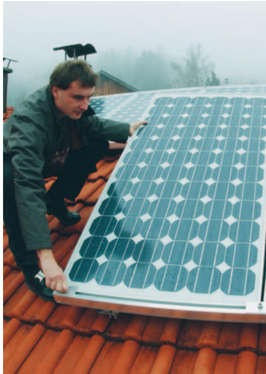
Montage einer Solarstromanlage
