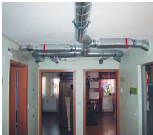
Sanierung: Installation einer Komfort-Lüftung – wird danach verkleidet
