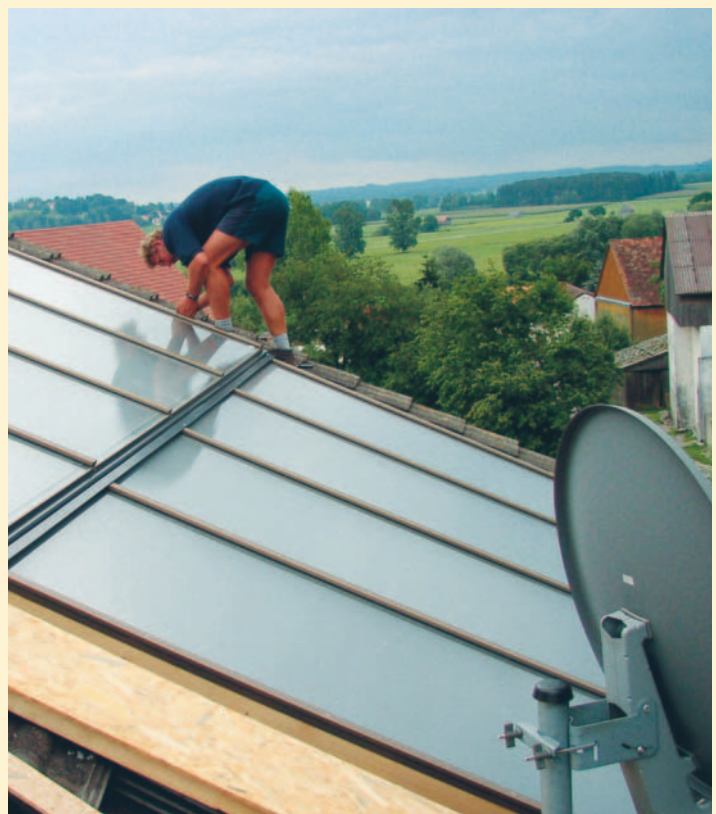
Montage eines Solarkollektors
