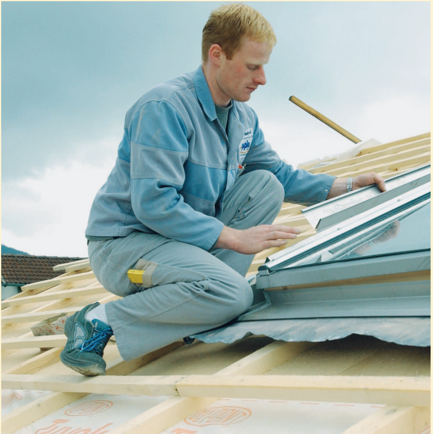
Montage einer Solaranlage
