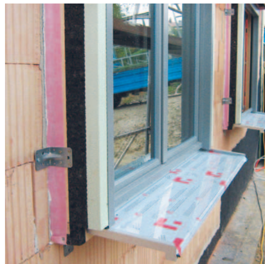
Fenster sollten in die Dämmebene eingebaut werden. Wenn wie hier nachher ein Wärmedämmverbundsystem angebracht wird, dann werden die Fenster nach außen gesetzt.
