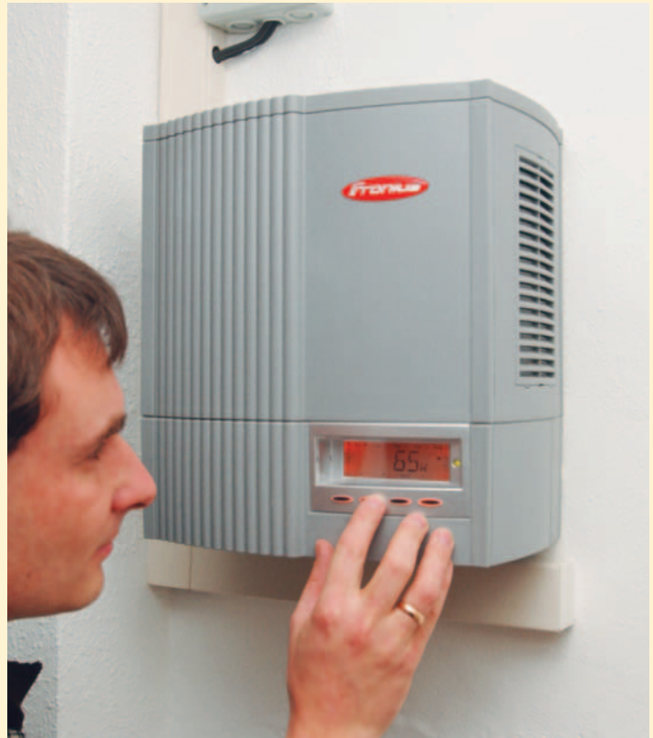
Wechselrichter einer Solarstromanlage
