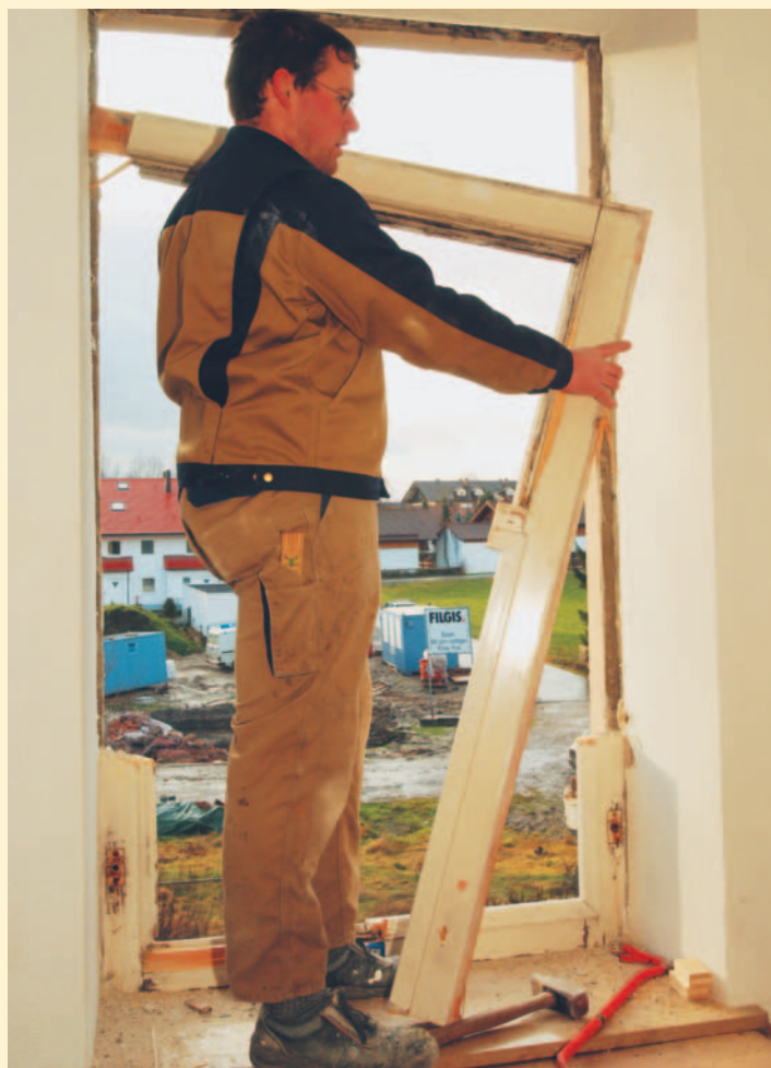
Demontage eines alten Fensters
