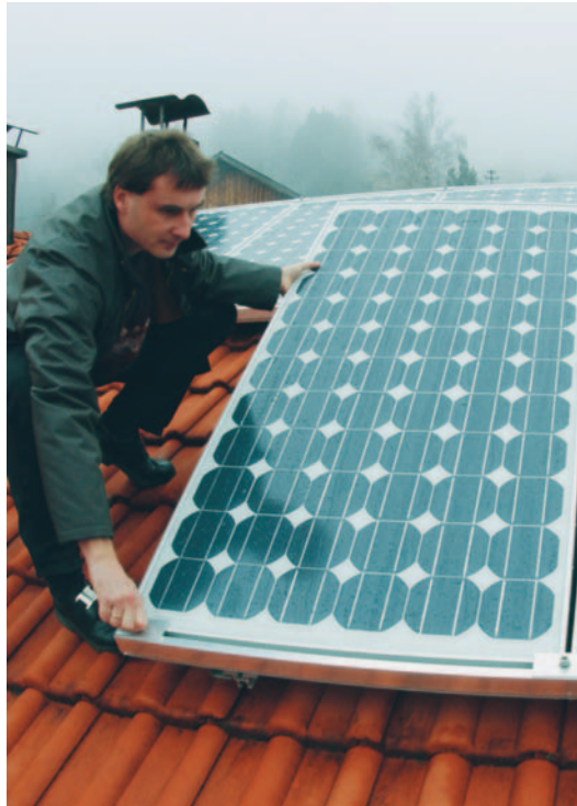
Montage einer Solarstromanlage
