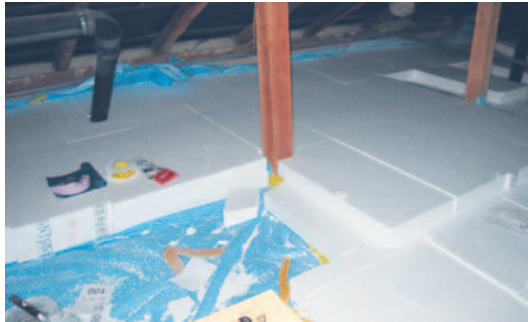
Die Dämmung der obersten Geschossdecke ist einfach und rechnet sich fast immer. Foto: may.schurr.architekten
