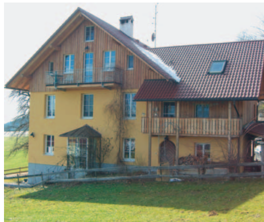
Bei der Sanierung dieses Gebäudes im ländlichen Westallgäu konnte ein um 30 % besserer Energiestandard als bei einem durchschnittlichen Neubau erreicht werden.
