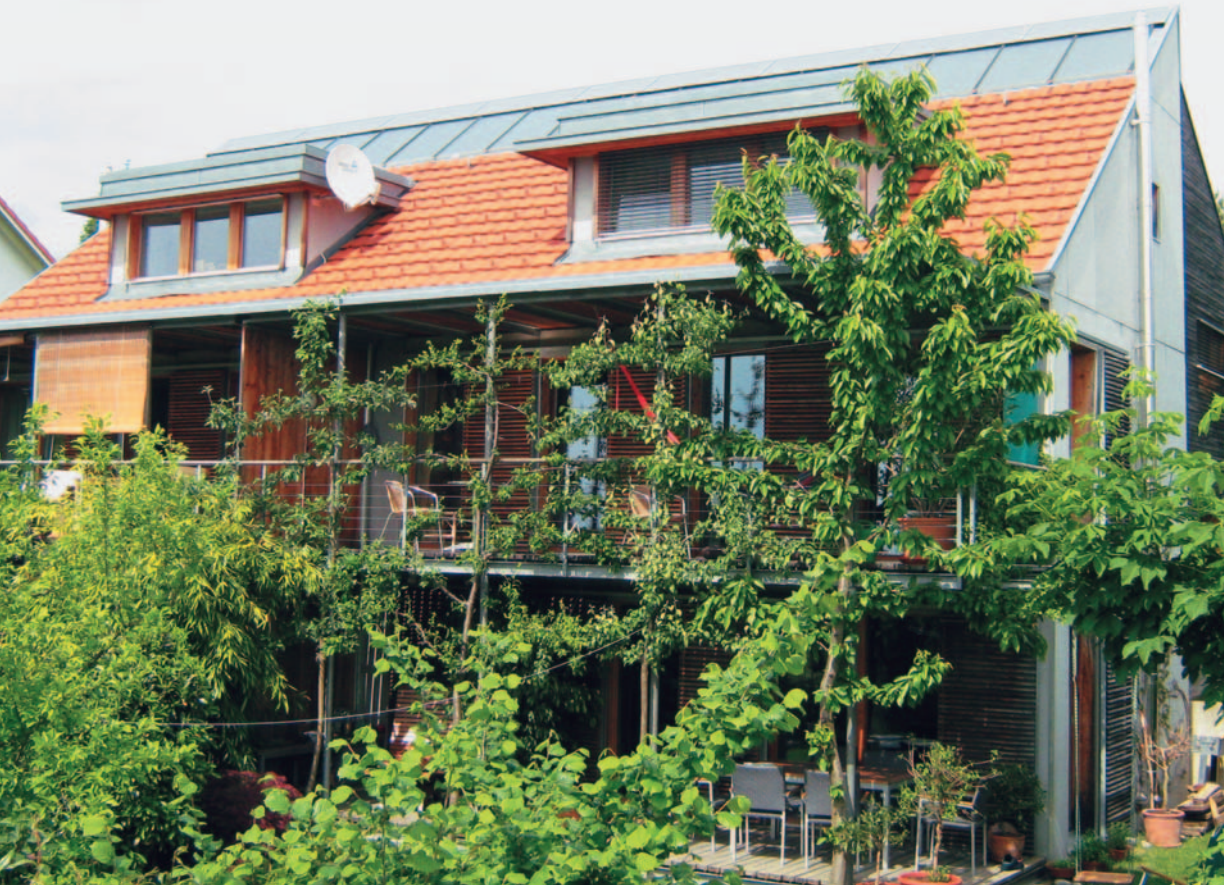
Bereits gut eingewachsen ist das Passivhaus nach 8 Jahren
