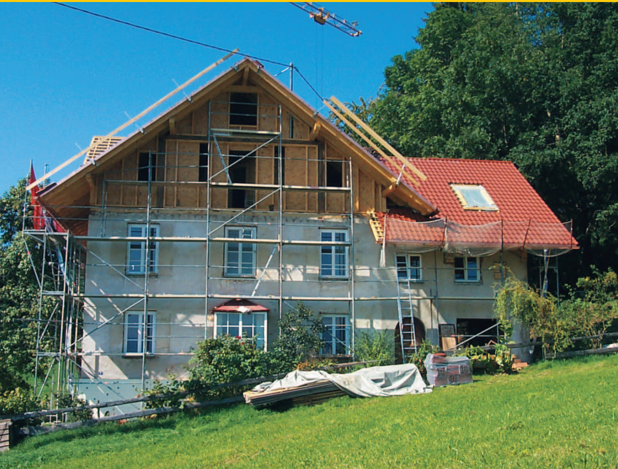
Der Dachstuhl und das Dachgeschoss wurden erneuert.
