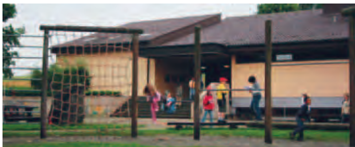
Grundschule mit Turnecke
