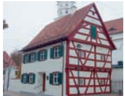
Sanierung Benefiziatenhaus Illertissen
