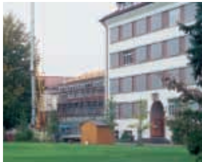
Gebäudeaufstockung Kolleg der Schulbrüder
