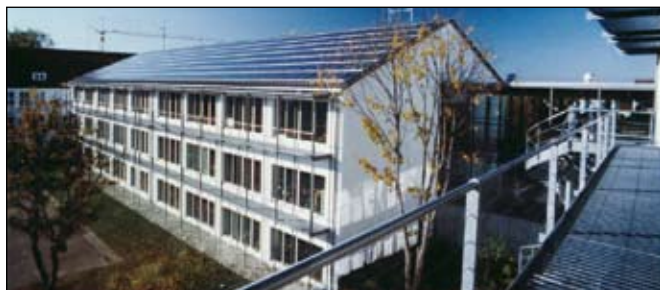
Solaranlage auf dem Dach des Mittelbaus der Schule Straß
