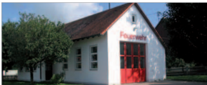
Feuerwehrgerätehaus in Dietershofen
