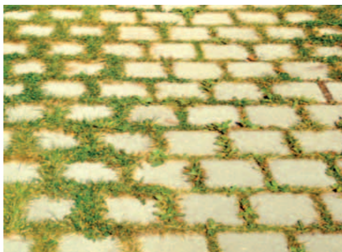
Betonpflaster mit Rasenfuge
