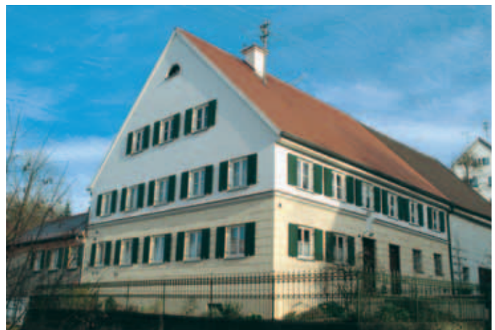
Saniertes ehemaliges landwirtschaftliches Anwesen in Deisenhausen
