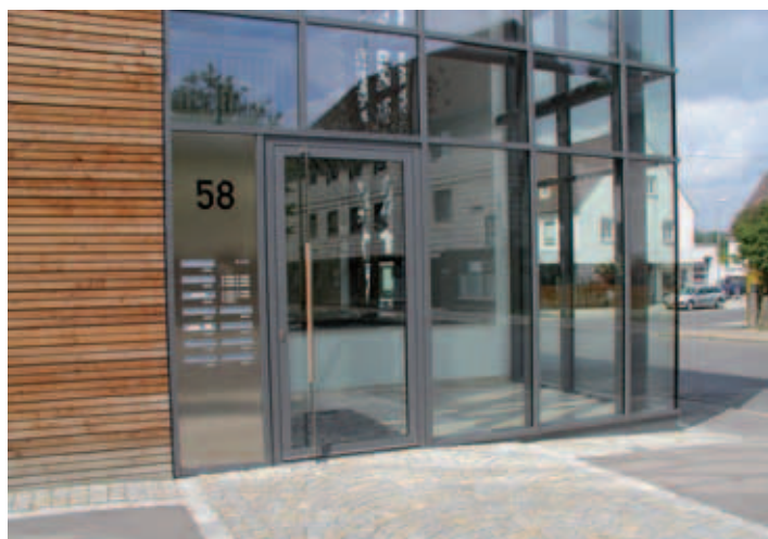
Barrierefreier Zugang einer Wohnanlage in Krumbach
