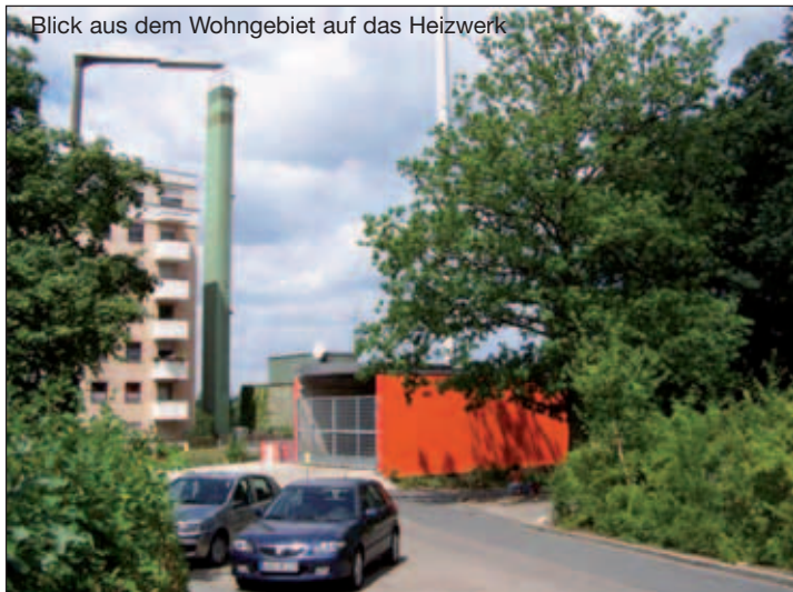
Blick aus dem Wohngebiet auf das Heizwerk
