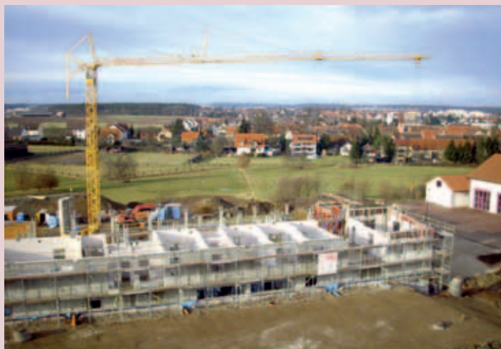
Rohbau neuer städtischer Bauhof
