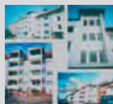
Neubau MFH Planung und Bauleitung
