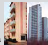
Eigentums- Wohnanlagen Betoninstand- setzung
