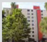
Eigentums- Wohnanlage Fassadenin- standsetzung Wärmedämmung
