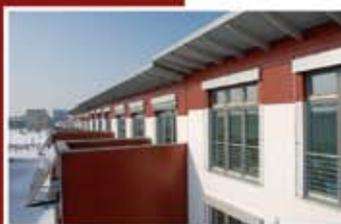
Sonnenkollektoren, die an der Brüstung der Balkone angebracht werden, sorgen für Warmwasserbereitung.
