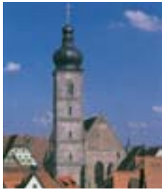
Pfarrkirche St. Martin St.-Martin-Straße
