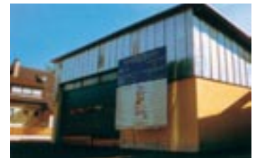
Wärmeversorgung mit regenerativer Energie: das Biomasseheizwerk an der Volksschule
