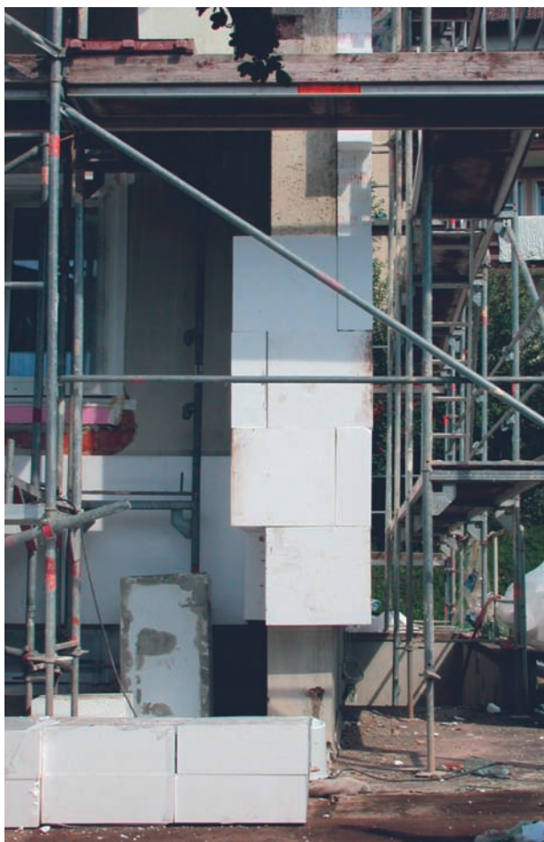
Fassadendämmplatten aus Polystyrol (Styropor)
