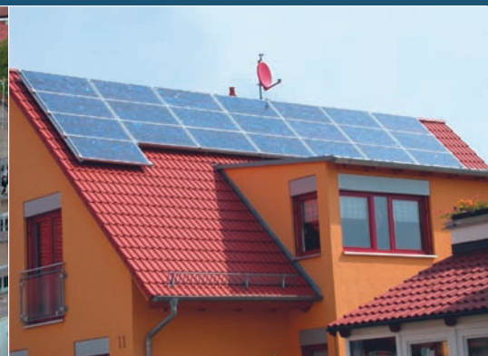
Photovoltaikanlage (3,6 kW) in Meinhardswinden
