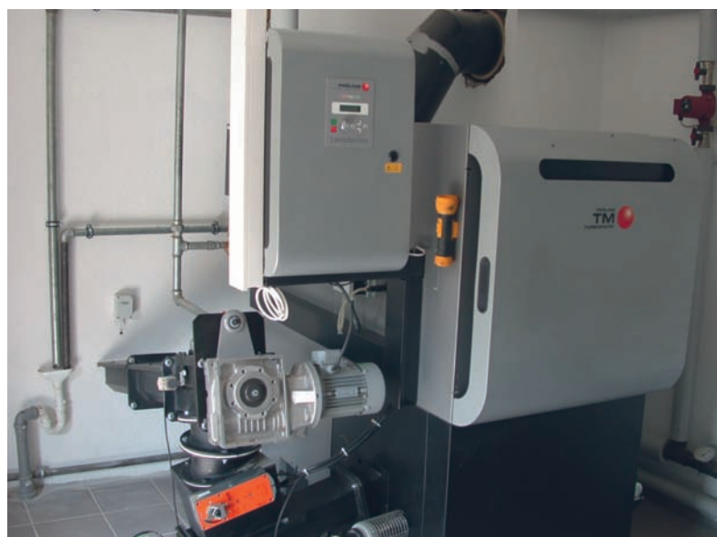
Hackschnitzelheizung mit Lambda-Sonde
