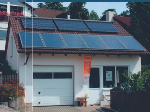
Röhrenkollektoren und Flachkollektoren
