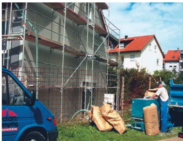
Einblasen von Zellulose-Dämmung
