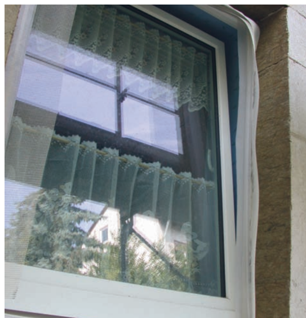
Fachgerechter Einbau der Fenster ist wichtig
