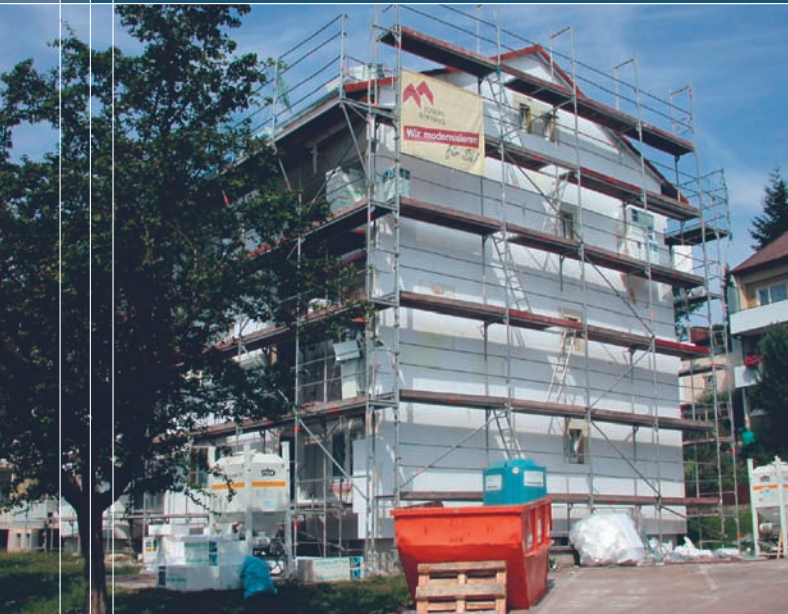
Dollmannstraße 47 - Ostfassade mit Außenwanddämmung
