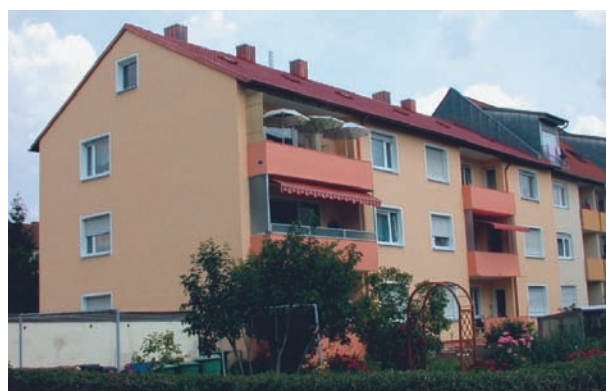
Saniertes Haus im Holbeinweg
