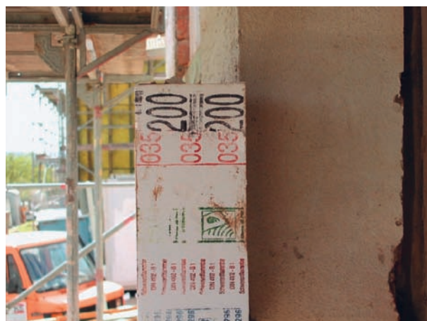
Fassadendämmplatten aus Polystyrol (Styropor)
