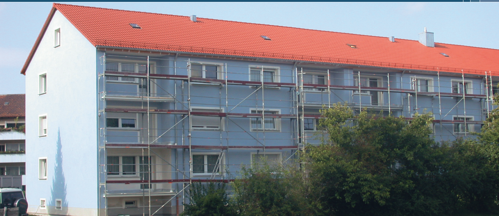
Saniertes Mehrfamilienhaus – Theodor-Alt-Weg
