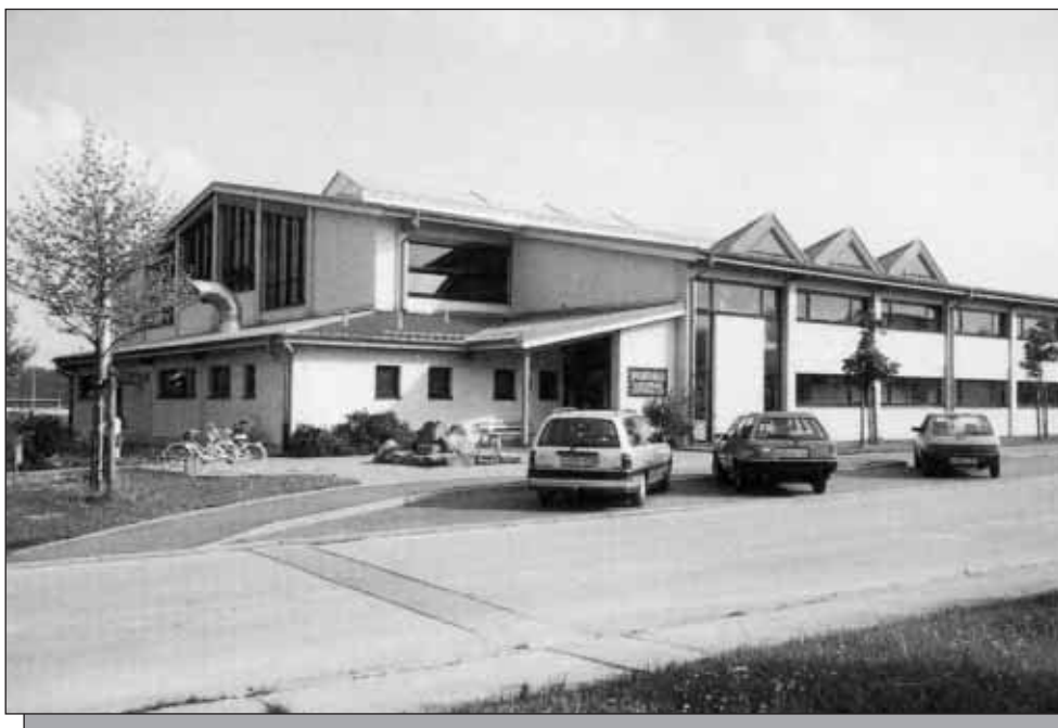
Die Doppelturnhalle des Schulverbandes Leutershausen an der Gottfried-Blendinger-Straße Foto: Konrad Bickert
