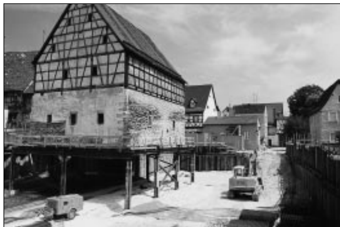
Die „aufgestützte“ Bärenscheune und ein Teil der Baugrube des „Neuen Rathauses“ im Jahre 1993
