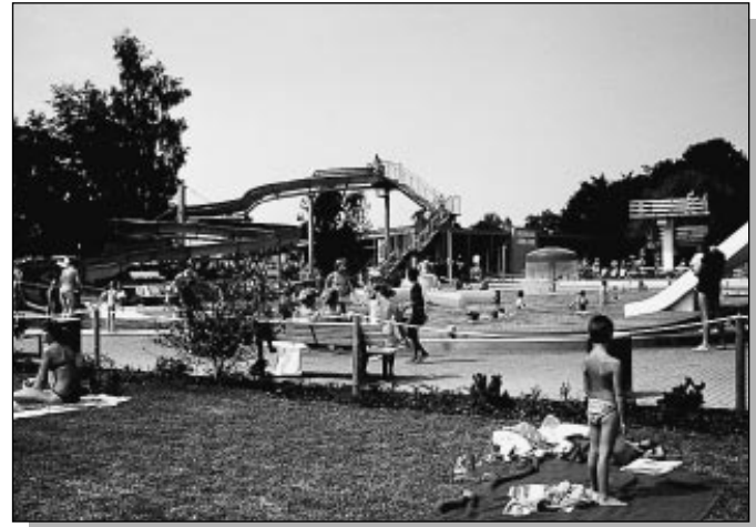
Das Limesbad nach der Beckensanierung
