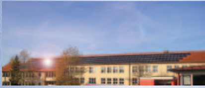
PV-Anlage Schule Ammersricht, Bürgerbeteiligungsanlage
