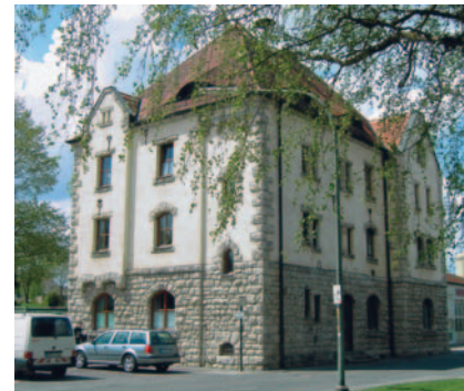
Ehemaliges Bahnhofgebäude der Regionalbahn Lauterhofen-Amberg
