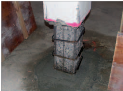
Sanierung einer Betonstütze
