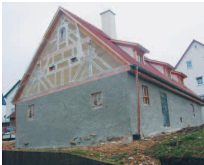
Ein in der Sanierung befindliches Wohnhaus in Wissing
