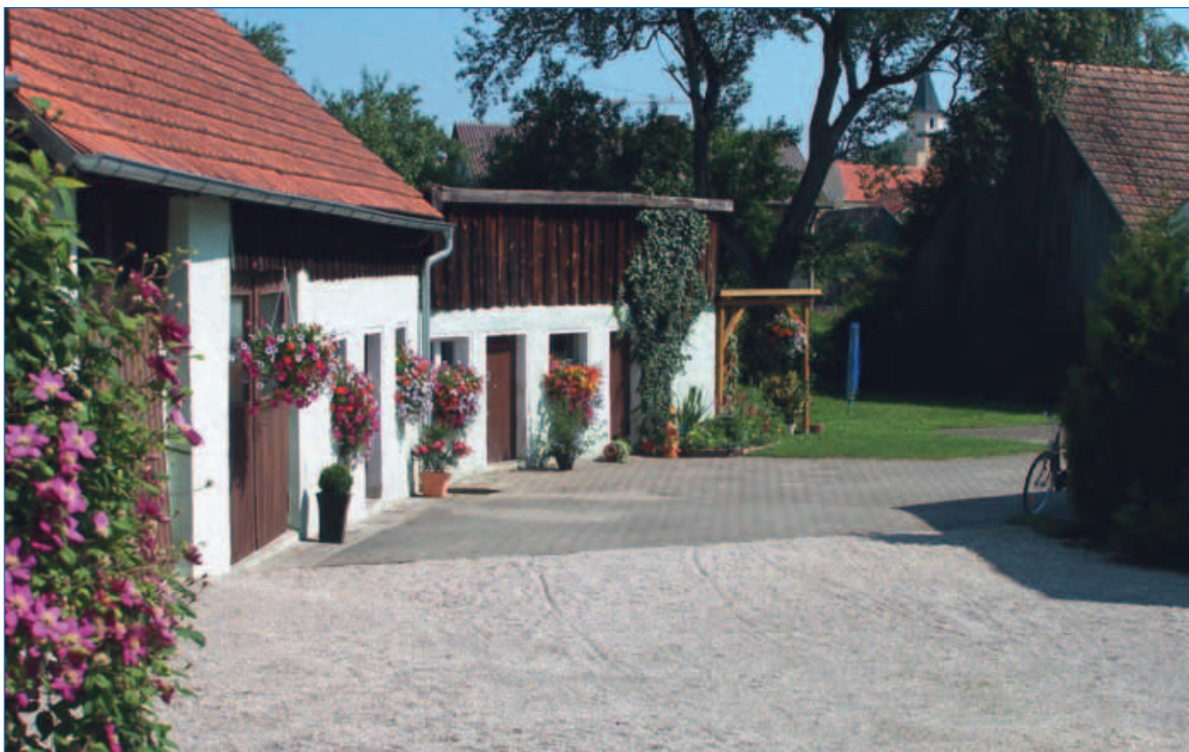
Denkmalschutz und die Pflege von alten Gebäuden sind eng miteinander verbunden
