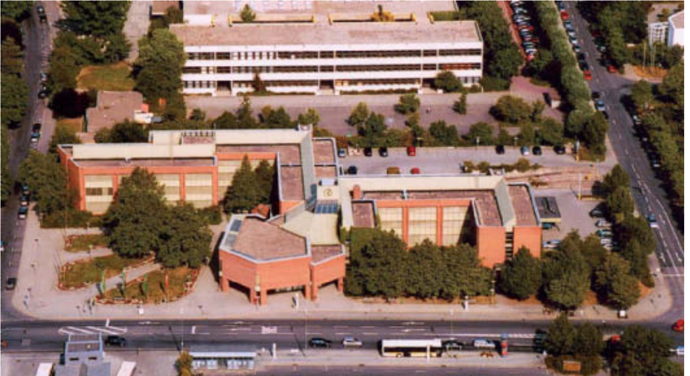
Neues Rathaus in den Naabwiesen, direkt beim Zentralen Omnibusbahnhof (ZOB)
