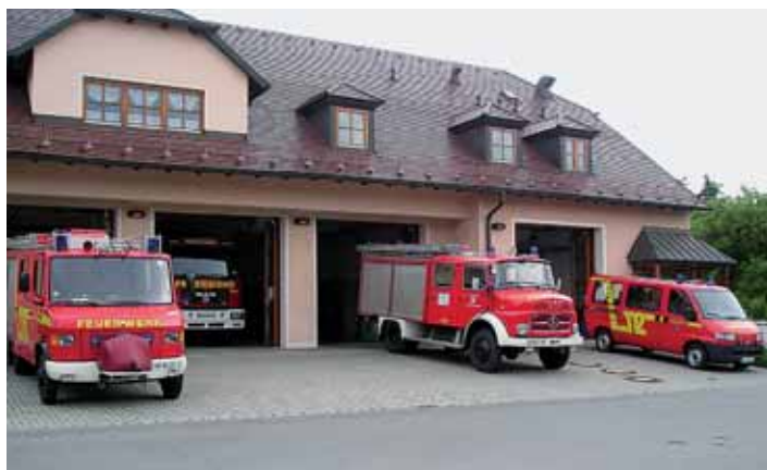
Feuerwehrhaus im Haidmühlweg
