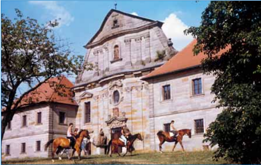
Renovierte Westfassade der Kirchenruine Barbaraberg
