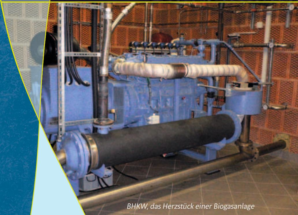
*BHKW, das Herzstück einer Biogasanlage*
