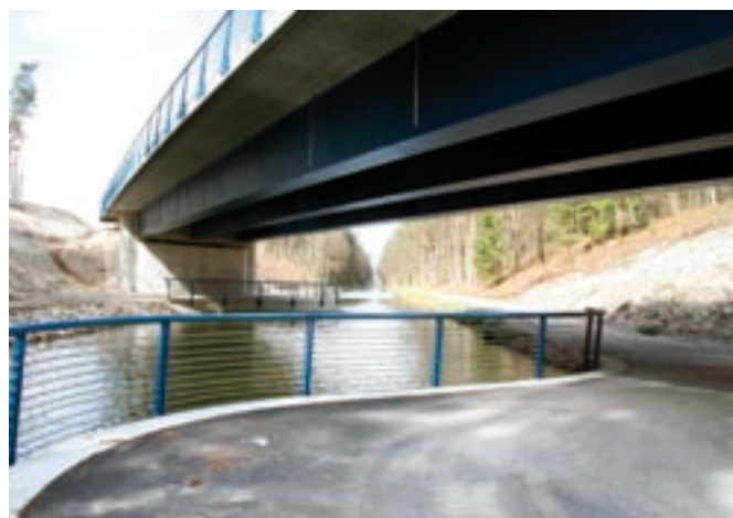
Abbildung: Neubau der B299 bei Neumarkt (Bauwerk 4.1)
