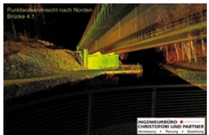
Abbildung: Obiges Bauwerk, gescanned mit einer Leica „Scanstation 2“
